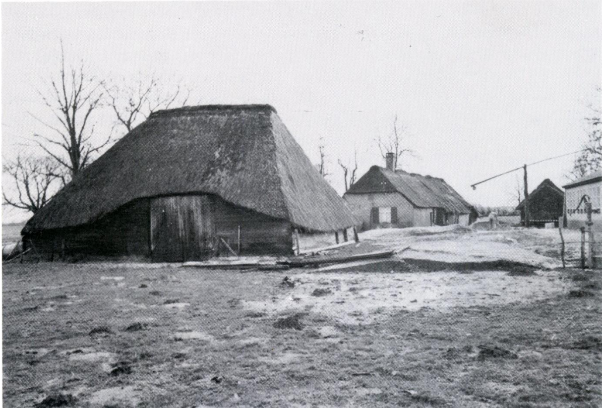
Opa Frans van de Laar boerde van 1908 – 1914 in dit boerderijtje op het Hoog Spul
