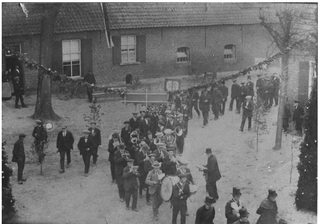
Vóór dit pand uit 1716 op de Diessense Heuvel stond er het Out Huis van mr. Bartholomeus de Cort
