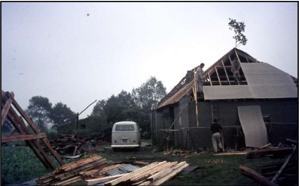
Het oude dak wordt verwijderd en vervangen in 1969 door het aannemersbedrijf van Piet Schilders uit Diessen.
