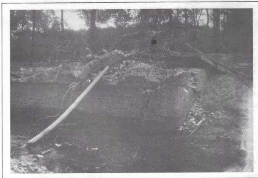
In mei 1940 maakte Jan Naajkens deze foto van de opgeblazen brug over het spruitenstroompje. Op de achtergrond zijn de bomen van Annanina's Rust te zien. Sinds de aanleg van de provinciale randweg is deze waterpassage een grond-duiker geworden en dus als brug moeilijk herkenbaar. Foto Collectie De Doornboom
