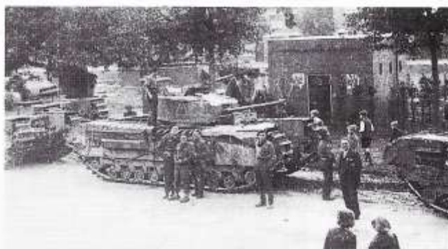
Zware Engelse tanks voor het transformatorhuisje op de marki.
