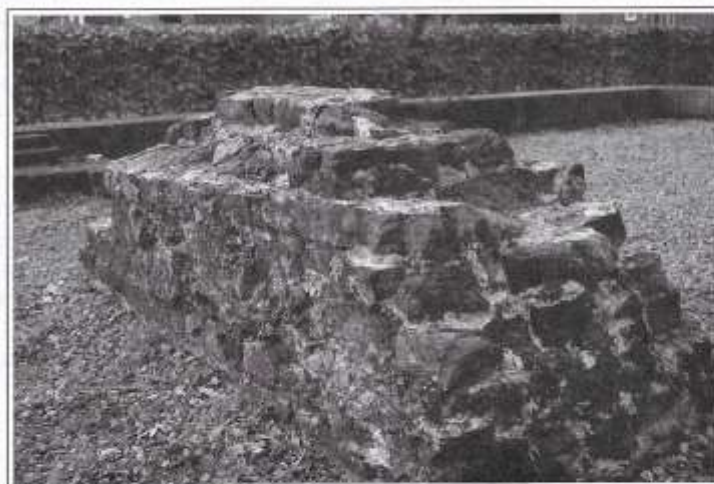
Opgegraven restant van de tussen- of brandmuur van de dekanij. Nu opgenomen in monument in de woonwijk Ijpelaer
